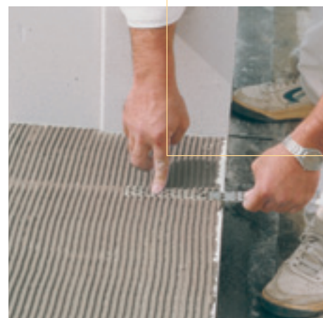
Spojka zdiva aplikovaná při stavbě nosné konstrukce.
